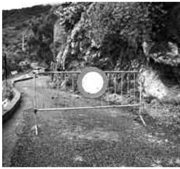
P. T. LA STRADINA RESA «OFF LIMITS» PER PRECAUZIONE [FOTO SANTISI]
